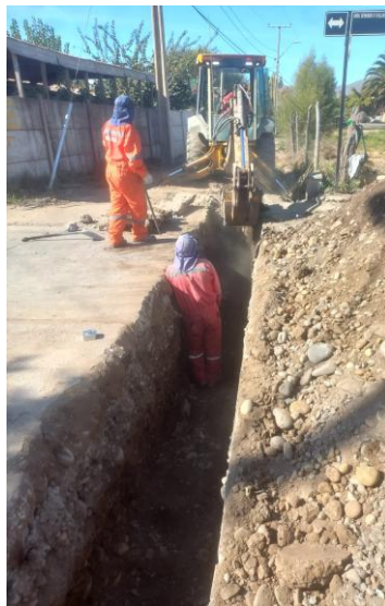
Trabajo de excavación para instalación de tuberías de HDPE.
