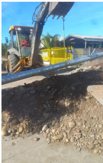
Trabajo de excavación para instalación de tuberías de HDPE.
