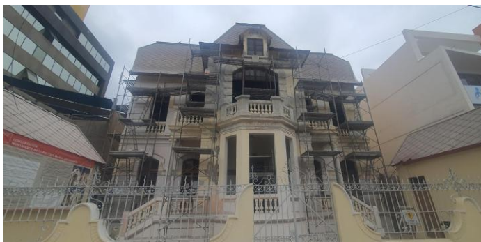
Trabajos de pintura en fachada oriente hacia el Parque Brasil.
