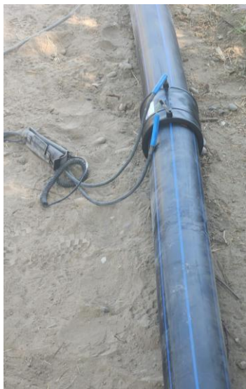
Trabajo de instalación de las tuberías de HDPE, construcción de aceras y atraveso de Berta Zamorano y cámara de conexión en la Ruta H-30.
