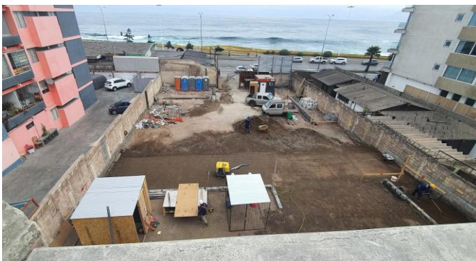
Trabajos de nivelación de terreno y relleno compactado en el patio posterior del edificio histórico.
