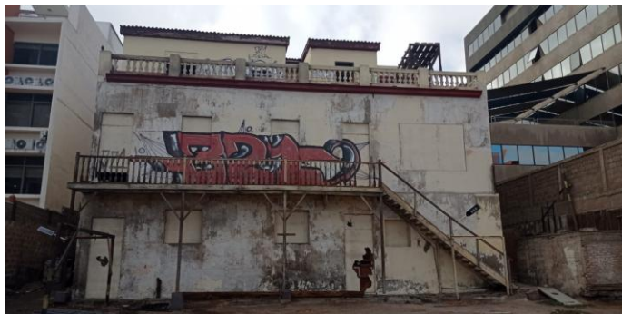
Recuperación de fachada poniente en casa Abaroa.
