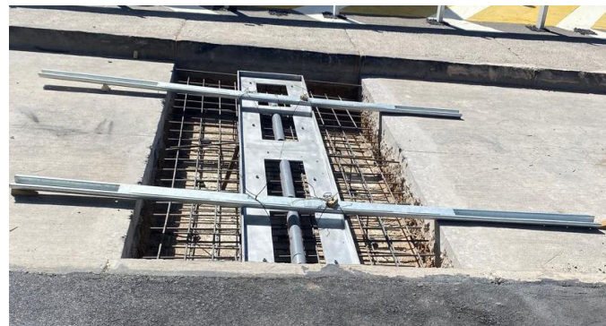
Construcción galpón estructura metálica y la instalación de placas de pesaje.
