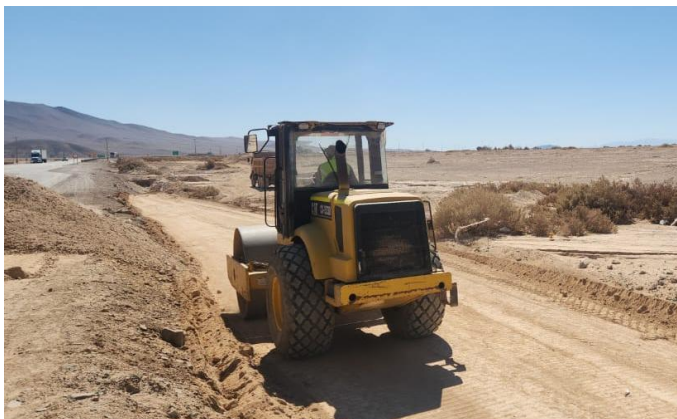
Movimientos de tierra y construcción de terraplén.
