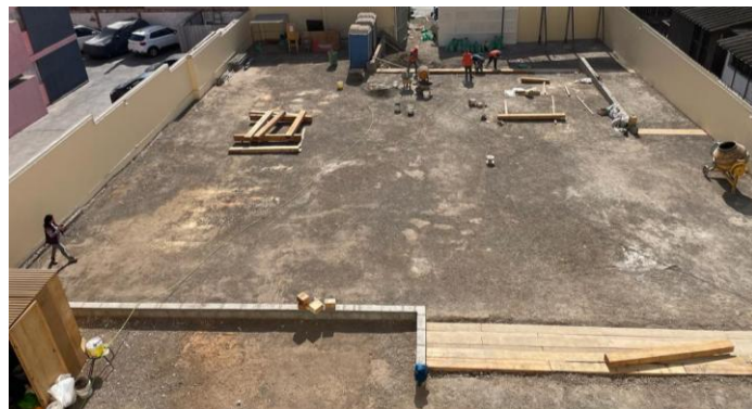
Trabajos de nivelación de terreno y relleno compactado en el patio posterior del edificio histórico.
