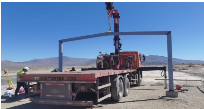
Construcción galpón estructura metálica y la instalación de placas de pesaje.
